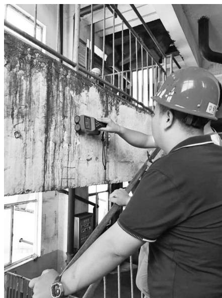
图2 钢筋探测仪检测混凝土构件
