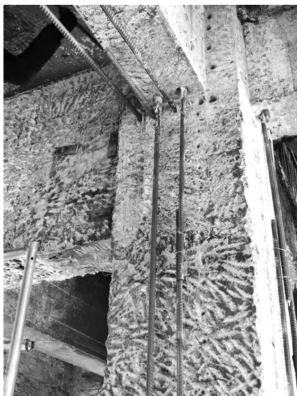
图1 混凝土构件新旧混凝土界面凿毛处理
