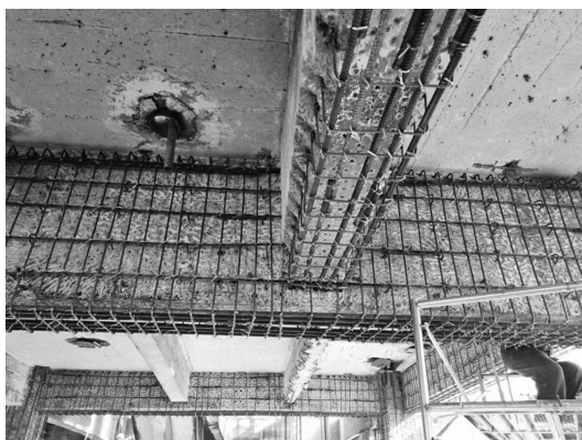
图3 混凝土构件植筋插孔
