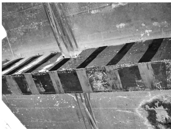
图4 混凝土构件碳纤维布加固
